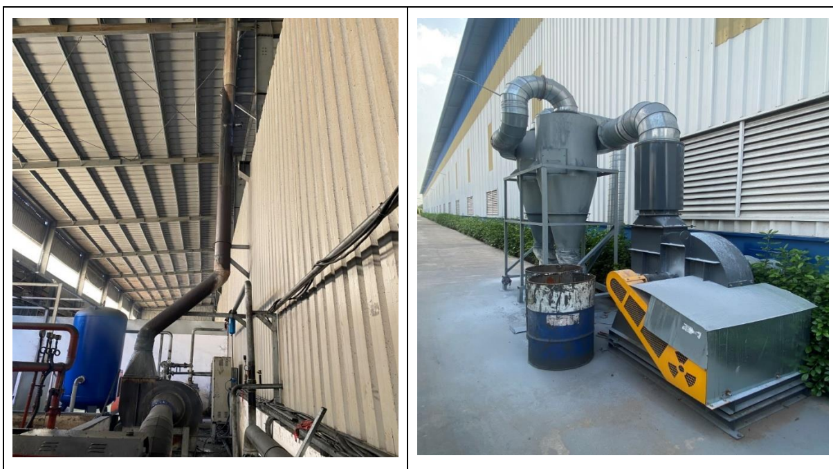
Hình 4.11. Mô tả quá trình thu gom hệ thống hút bụi kẽm tại Dự án
